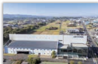
(平成27年に見学者ホール「しんぶん学聞館」を併設した山陰中央新報製作センター)
